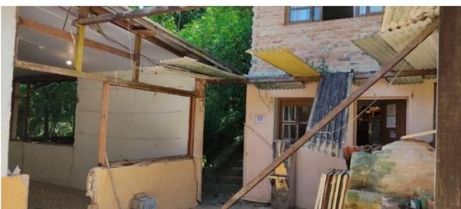
Conforme explicamos na proposta do projeto que foi enviado para as fundações, em virtude dos cupins, da madeira apodrecida e de erros de construção no passado, tivemos que demolir duas salas de aula e um
